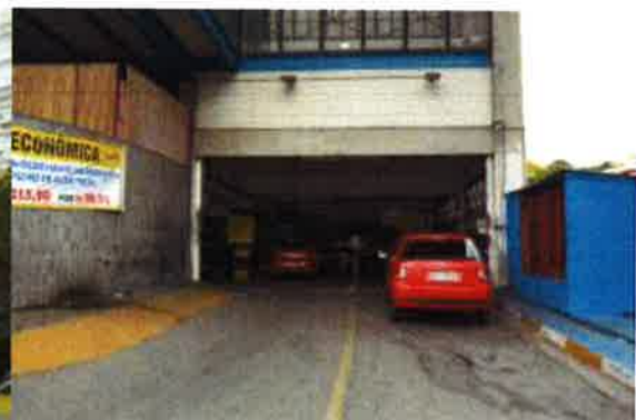
店舗に隣接するピット入口
